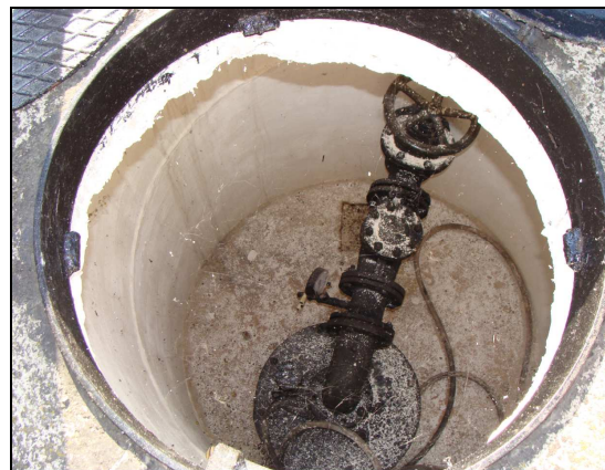
Ryc. 5. Uzbrojenie w studni nr 1A
